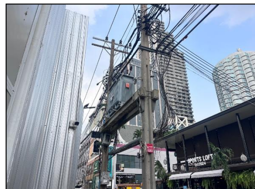
ภาพที่ 59 หม้อแปลงไฟฟ้า
