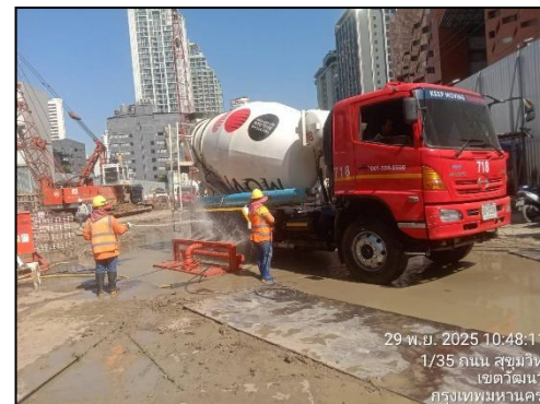
ภาพที่ 13 กิจกรรมล้างล้อรถบรรทุกและพื้นที่ล้างล้อ
