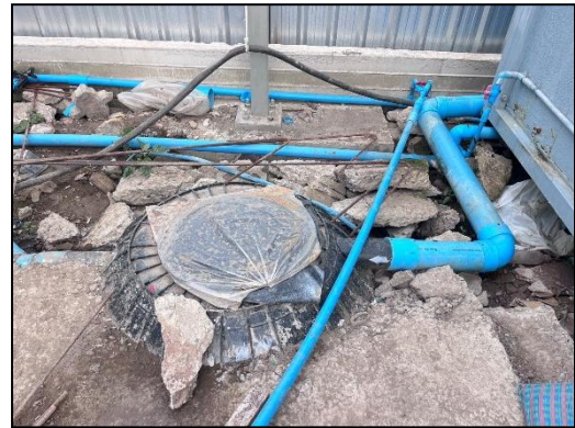
ภาพที่ 62 ระบบบำบัดน้ำเสียสำเร็จรูป
