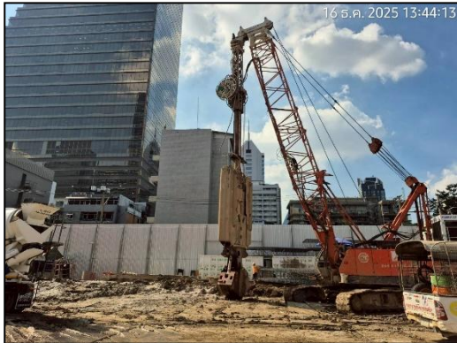
ภาพที่ 22 เสาเข็มเจาะ
